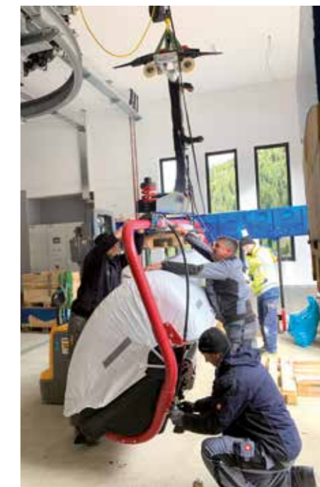
Sesselmontage in der Talstation
