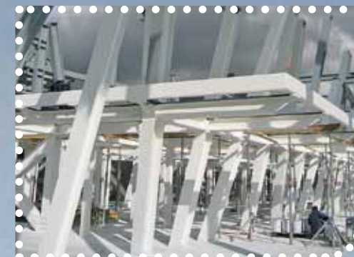
Bild 4: Stahlbau Restaurant Sommer 2005
